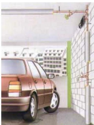
Osnovna svrha je sprečavanje smrzavanja hidrantskih vodova u garažama, na otvorenim površinama, šprinklerskih cjevovoda, cjevovoda rashladnih uređaja (chilera).
